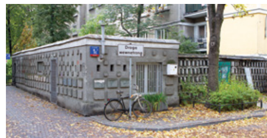
Wątki cegieł (cegła silikatowa, bloczki gruzobetonowe)
