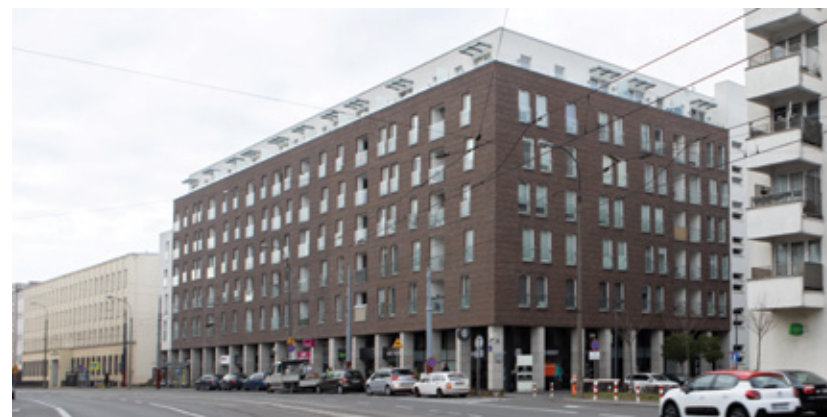
30 Zespół budynków wielorodzinnych, ul. Stawki 8, arch. Are Stiasny/Wacławek, Nagroda Architektoniczna Prezydenta m.st. Warszawy I edycji – III nagroda w kategorii zespół architektury mieszkaniowej, 2016)
